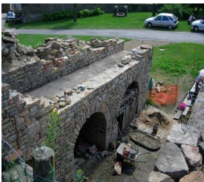
Avancement des travaux aux fours à plâtre
